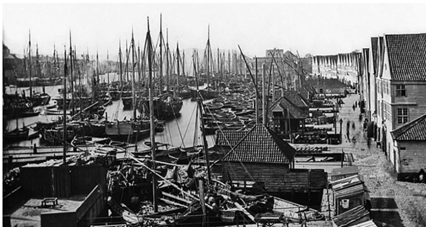
Figur 2. Bryggens livsnerve var forbindelsen til sjøen. Foto fra ca 1865. https://foto.bergen.kommune.no/fotoweb/archives/5007-Foto/Bilder/b2055.jpg
