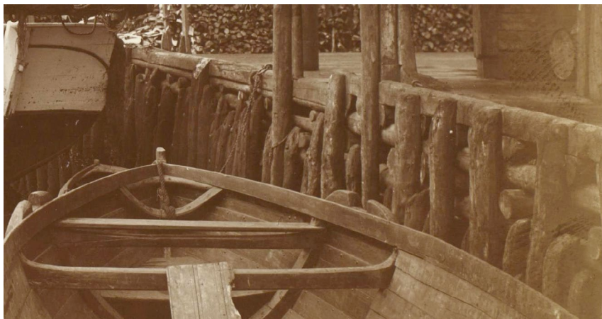
Figur 5. Detalj av foto av båter foran Bryggen. Vi ser tydelig hvordan lagene i de to bolverkene ikke er sammenfallende, og hvordan det øverste laget til høyre ligger en bjelketykkelse (10-15 cm) over den til venstre. Udatert, trolig slutten av 1800-tallet. Ukjent fotograf. Ubb-bs-ok-11905.
