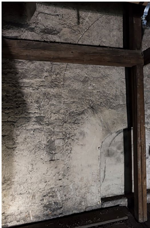
Vestgavlen sett fra gråstenshuset, 2019. Foto: Anders Amlø / Riksantikvaren.
