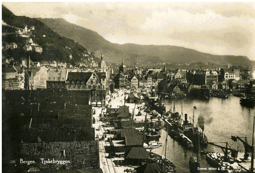
Figur 7. Komplisert kaibygging. Udatert foto, trolig tatt fra Nordenfjeldske Dampskibsselskab, fra tidlig 1920. Et typisk bilde som viser situasjonen med en kaimur som stikker nordover, men lar båttrafikk komme innenfor til bryggene. Gjenfyllingen er startet og kommet ca 50 m nordover. Rivingen av vareskur og bolverk er ennå ikke begynt. Det tyder på eiendomsoverdragelsene ikke er ferdige. Postkort fra Mittet & Co, fra Stiftelse Bryggens fotoarkiv.
