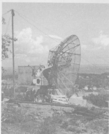
FuMo 214 Würzburg-Riese på Valdås fort. (Foto: ØSD, 1947.)
