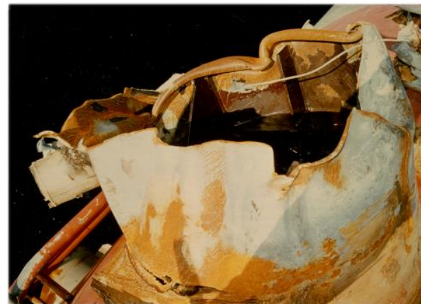
Fig. 9: Gjenstående del av stag TD 3. Dette er sterkt deformert. Bruddflaten gir også her inntrykk av at bruddet er et overbelastningsbrudd.
